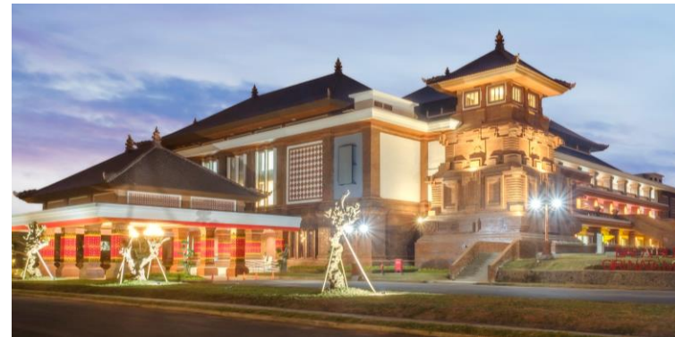
バリ芸術劇場建設工事
